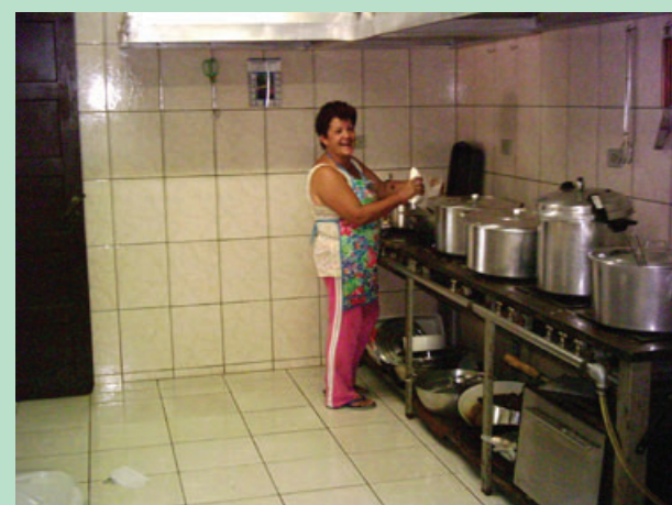
Cozinha totalmente reformada e equipada para melhor atender os hóspedes associados
